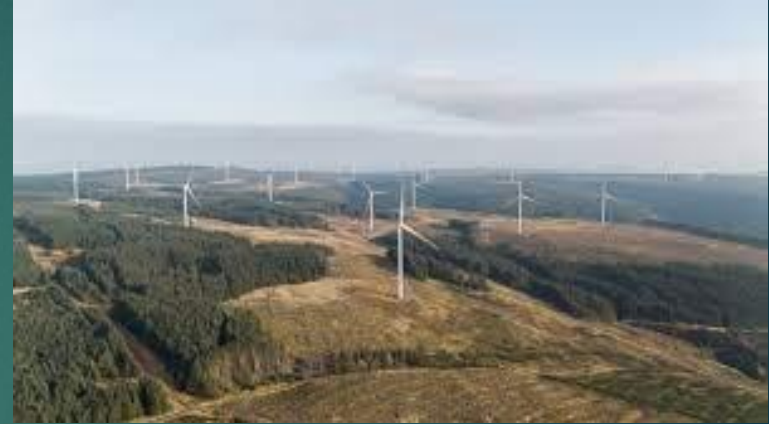
Pen y Cymoedd wind farm, S. Wales, 228MW dnc
